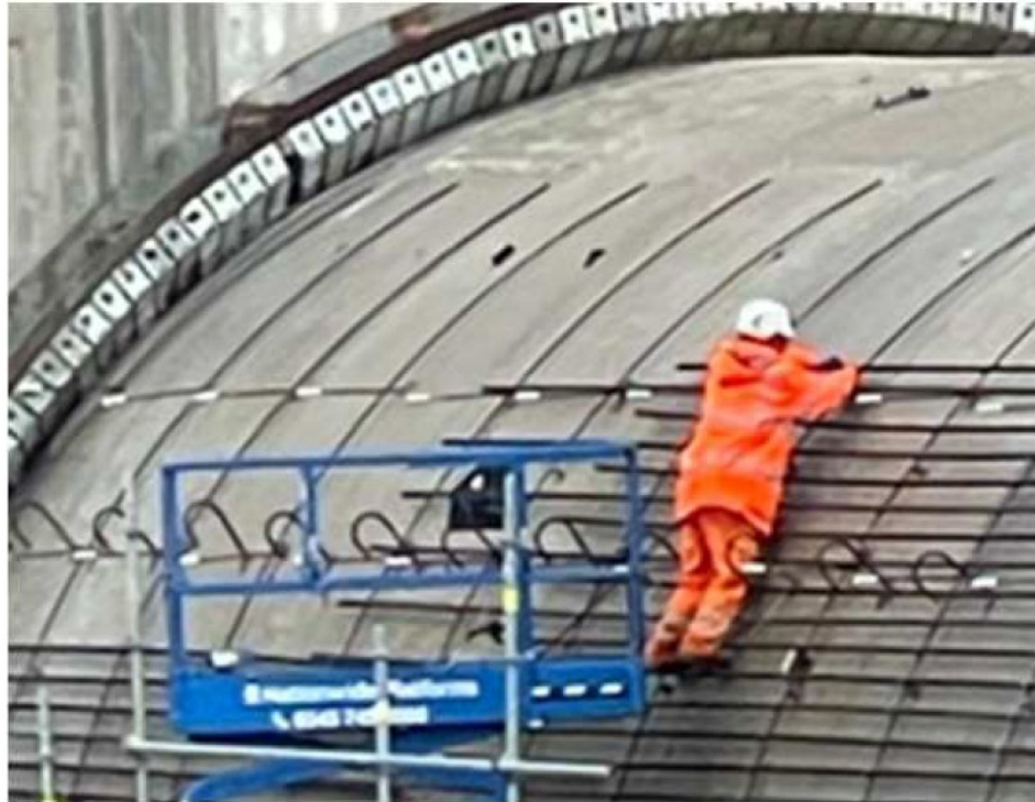
그림 3. 열차터널 외벽 공사작업 중 - 출처 (2)
