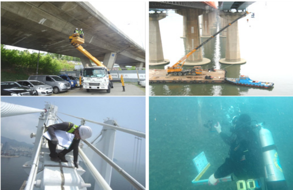
[그림 10] 육안관찰 등을 통한 시설물(교량) 안전점검
